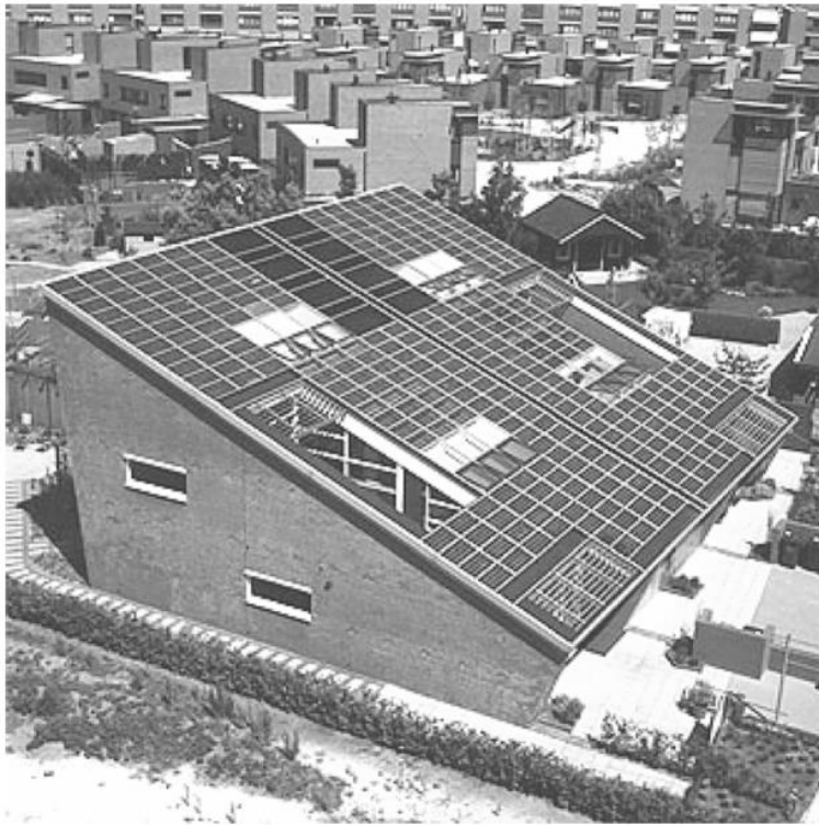
Fig. 1. Roofmounted Dutch PV Suburb, Nieuwland, Amersfoort.
